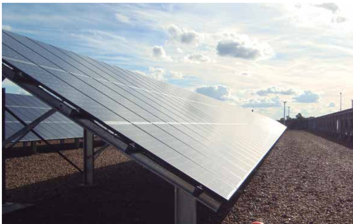
Proyecto para la Introducción de Energía Limpia por Sistema de Generación de Electricidad Solar con Japón.
