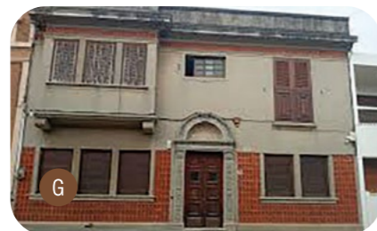
Sitio cultural residencia de Julio Vilamajó, Minas. (Archivo del Geoparque) Julio Vilamajó’s Residence Cultural Site, Minas. (Geopark archive)
