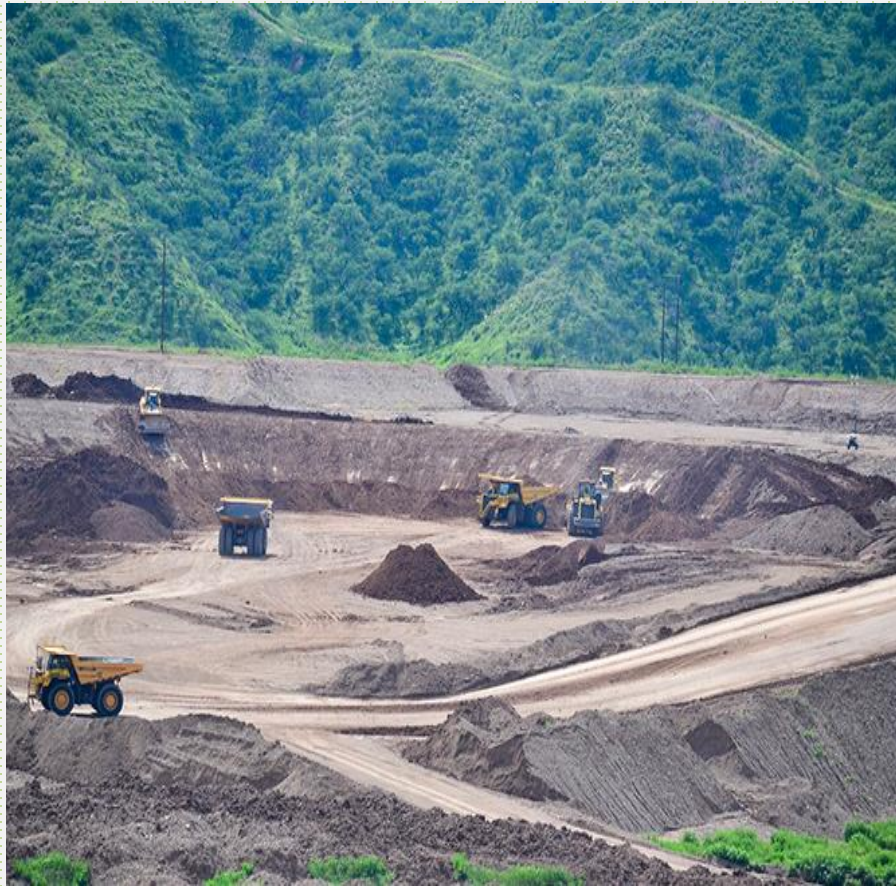
Perdida de vegetación, erosión
