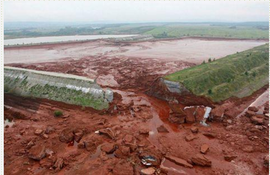
Ruptura de dique de cola
