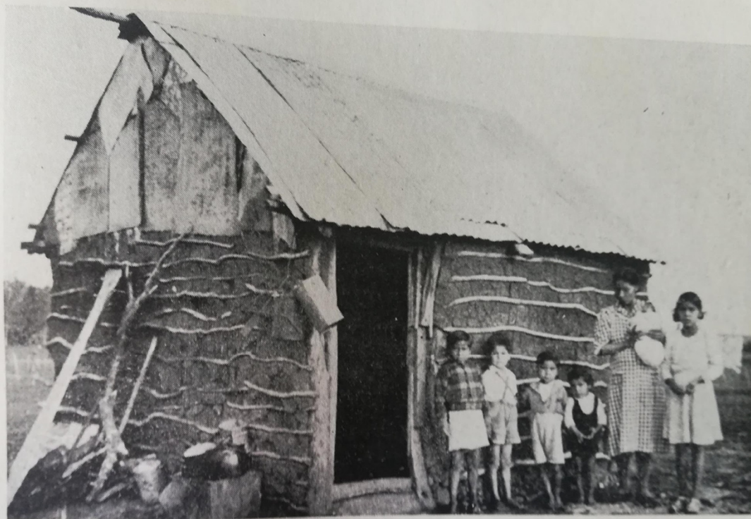
N.º 5.—Tipo de vivienda muy común en los puebluchos; rancho de "cebato", la más inferior de las construcciones. Tiene, sin embargo, el "lujo" del techo de zinc. Familia matriarcal. — Ranchario Tiatucura, Paysandú.
