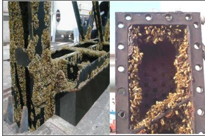
Figura 3. Estructuras hidráulicas colonizadas por Limnoperna fortunei en los Embalses del Río Negro.
