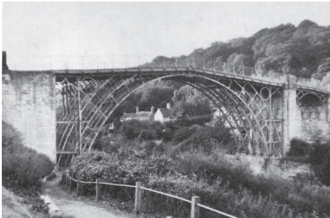
Figura 7.8 El puente de hierro.
