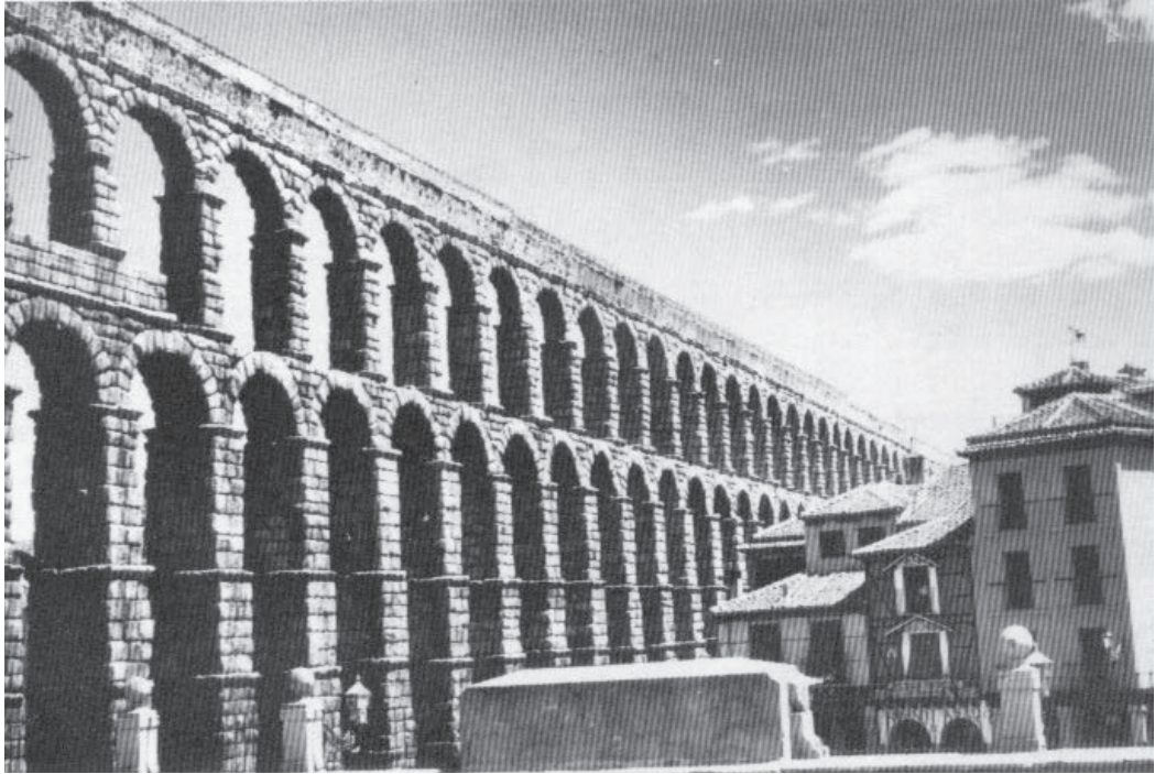
Figura 2.7 Acueducto de Segovia.
