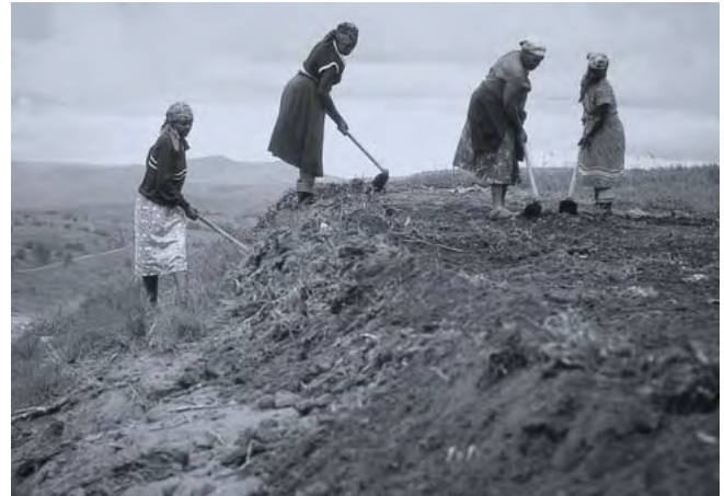
Mujeres locales realizan trabajos de rehabilitación en la Cantera Vryheid Coronation Colliery, Sudáfrica
