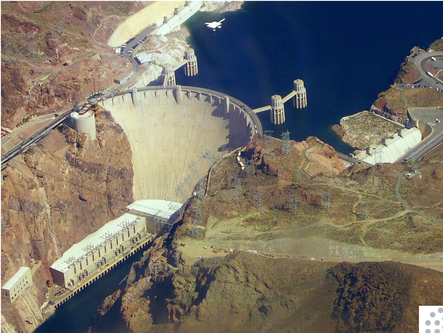
Hoover Dam (USA) 1936
