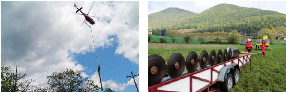
Figura 2.46. Trabajos de mantenimiento de vegetación próxima a líneas de alta tensión desde helicóptero y detalle de la sierra empleada
