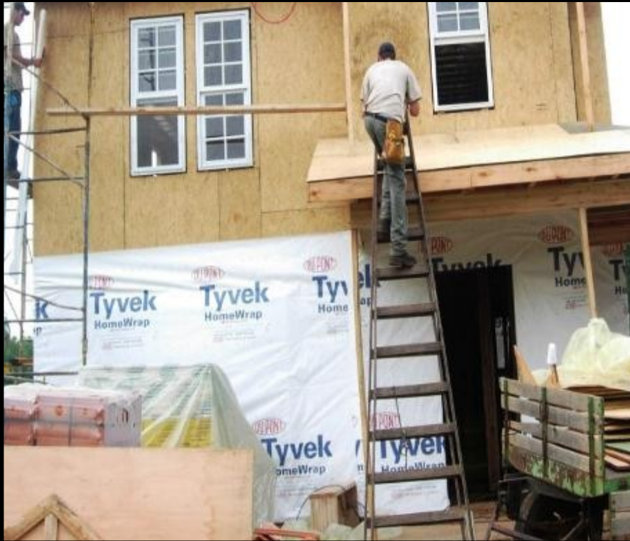
Instalación primer piso
