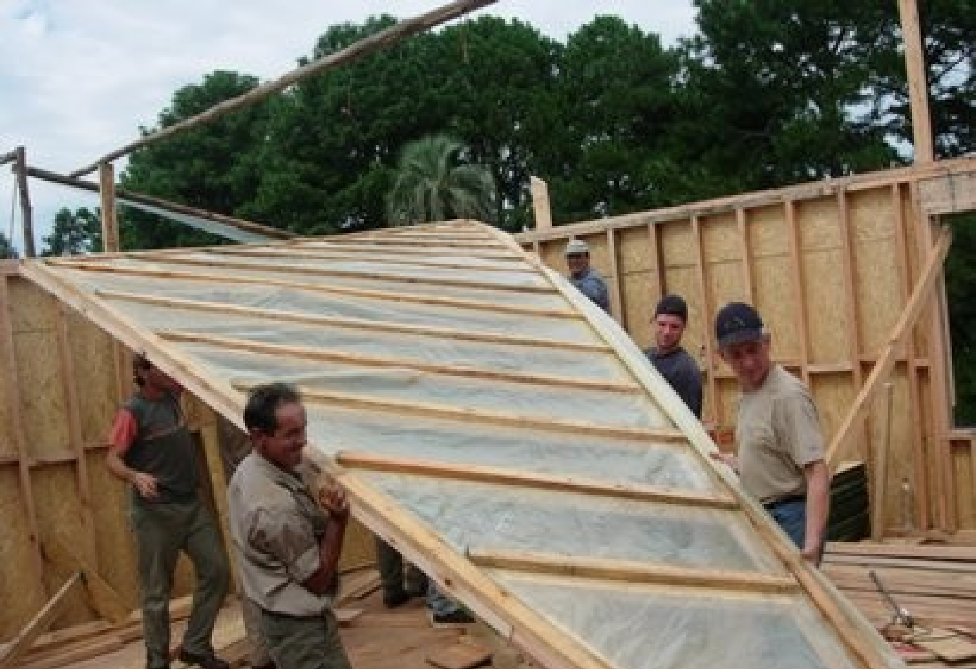
Casa INTA levantado manual cabriada tímpano 12 m
