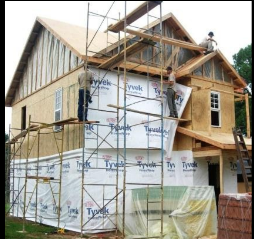
Instalación segundo piso
