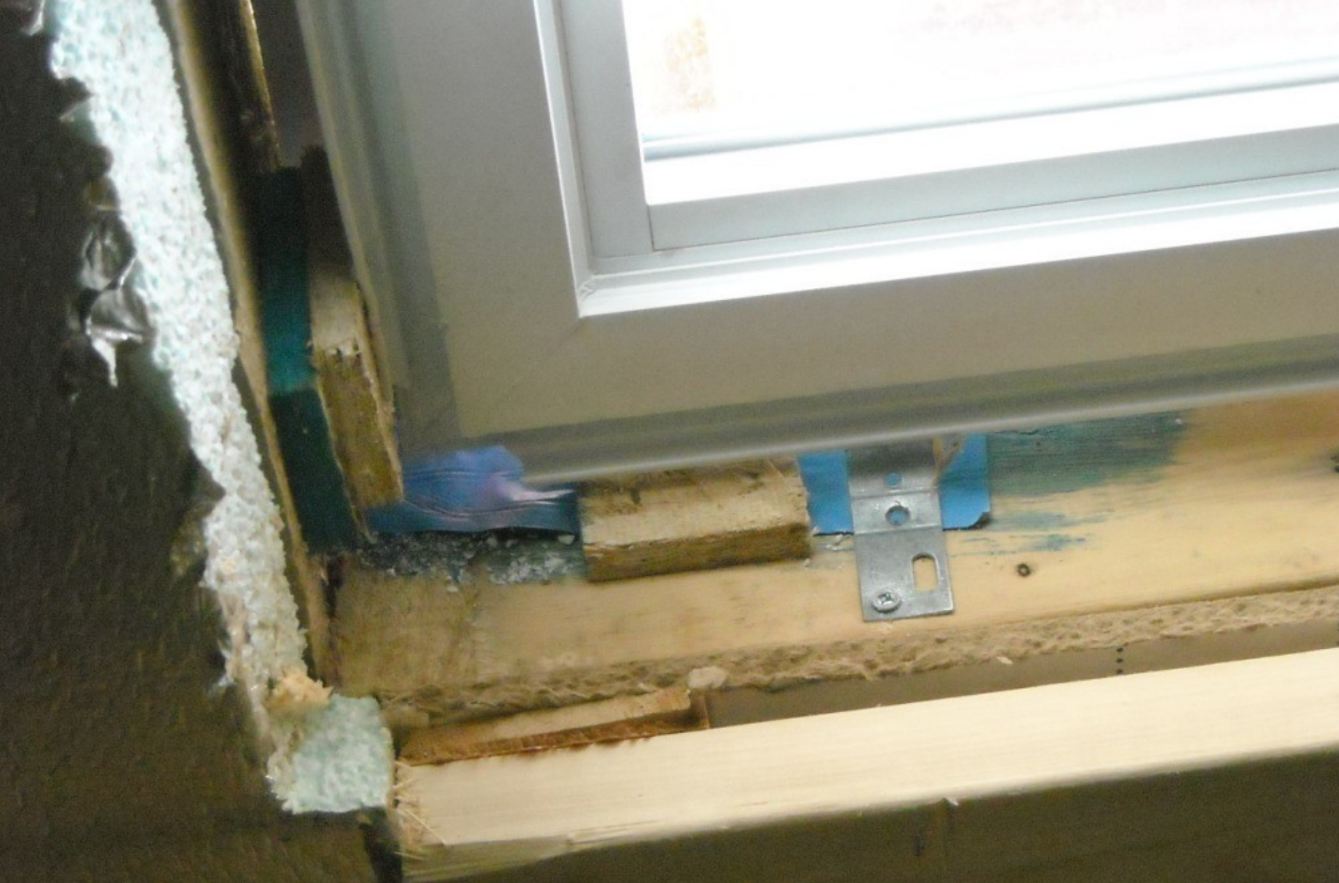
Pre-fijación de ventanas
