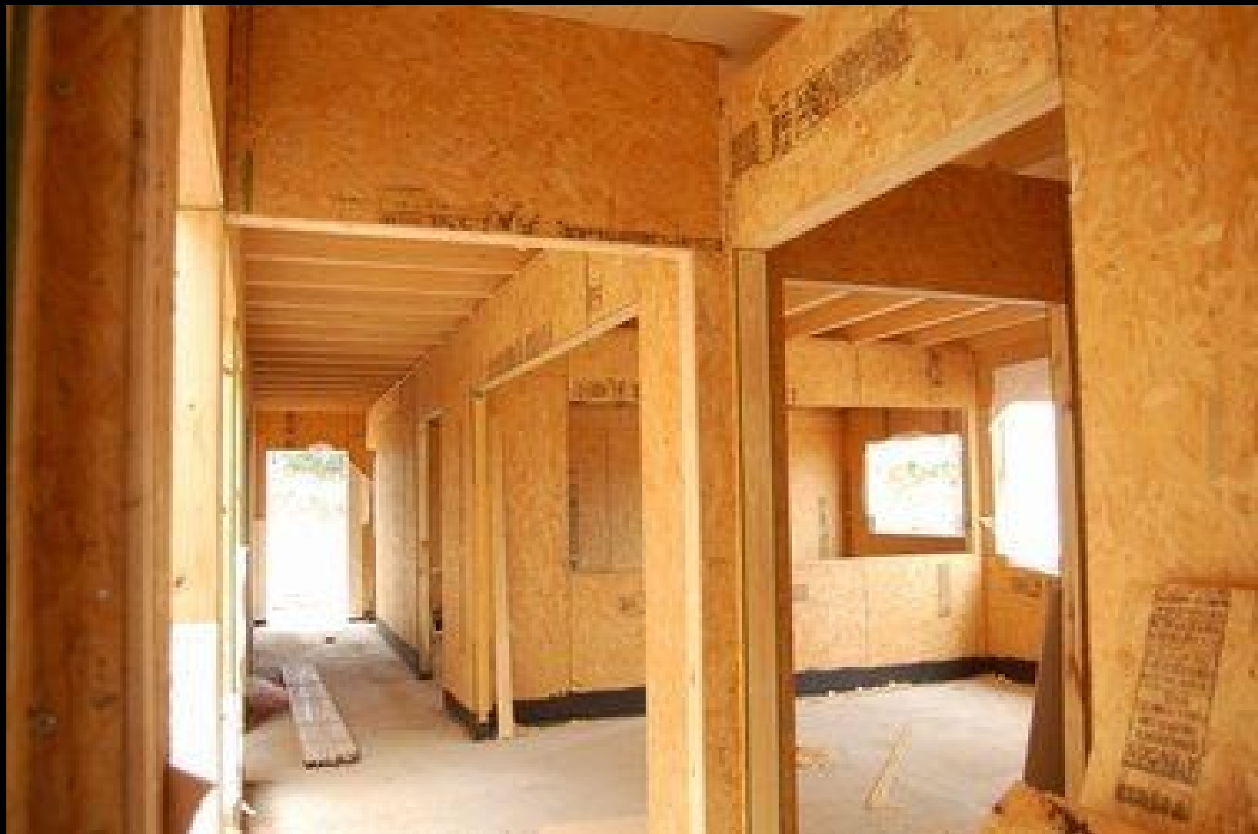
Paneles SIP en Concordia
