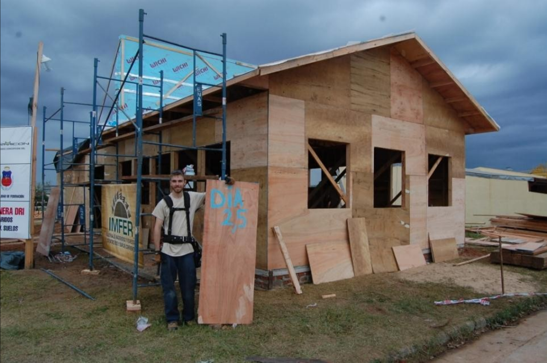
Fin día 2.5 Muros planta 2- rigidizado p. baja
