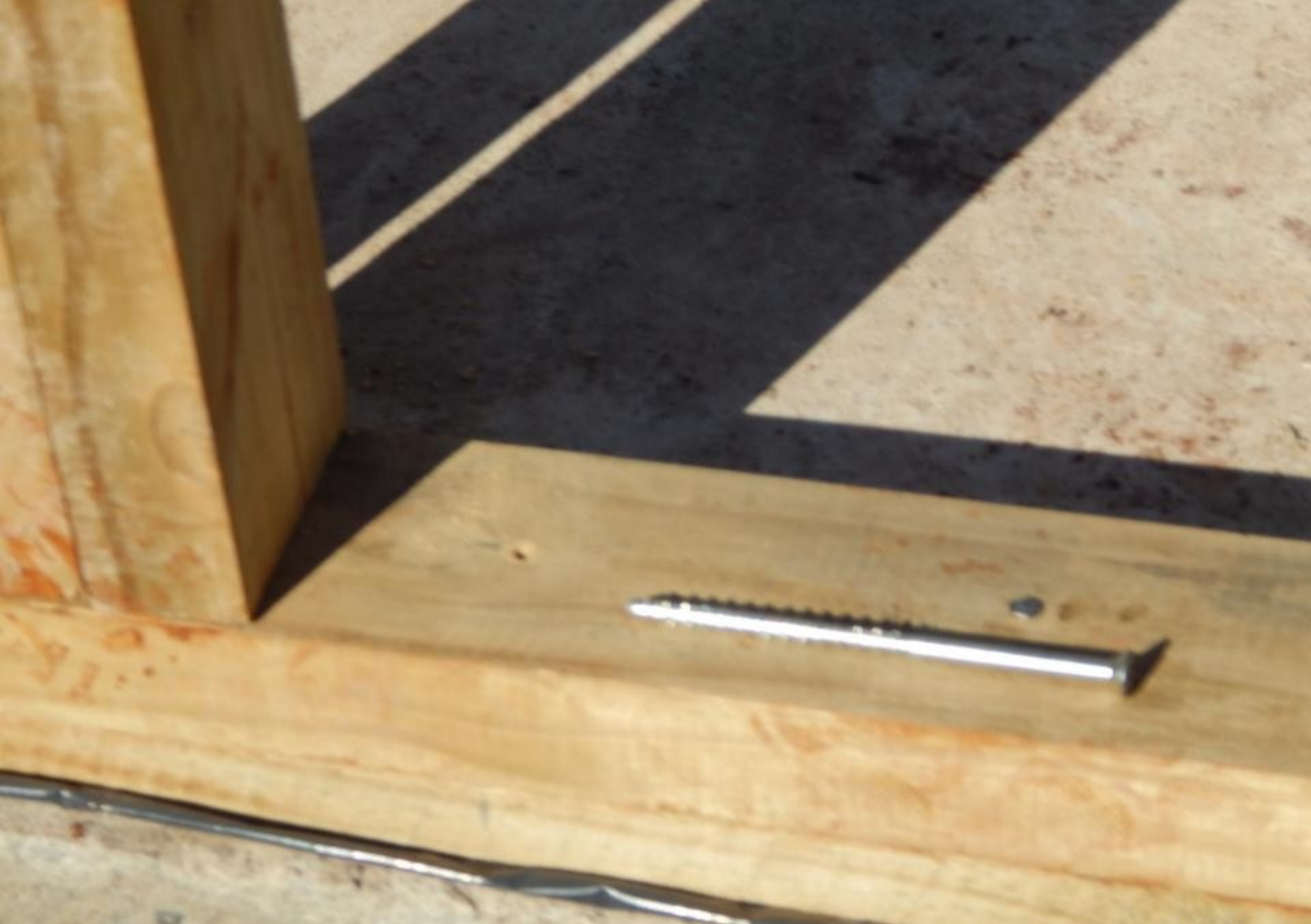
Fijación –anclaje directamente con tornillos, previo agujereado
