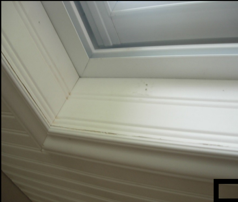
Detalle de unión en la esquina Instalado
