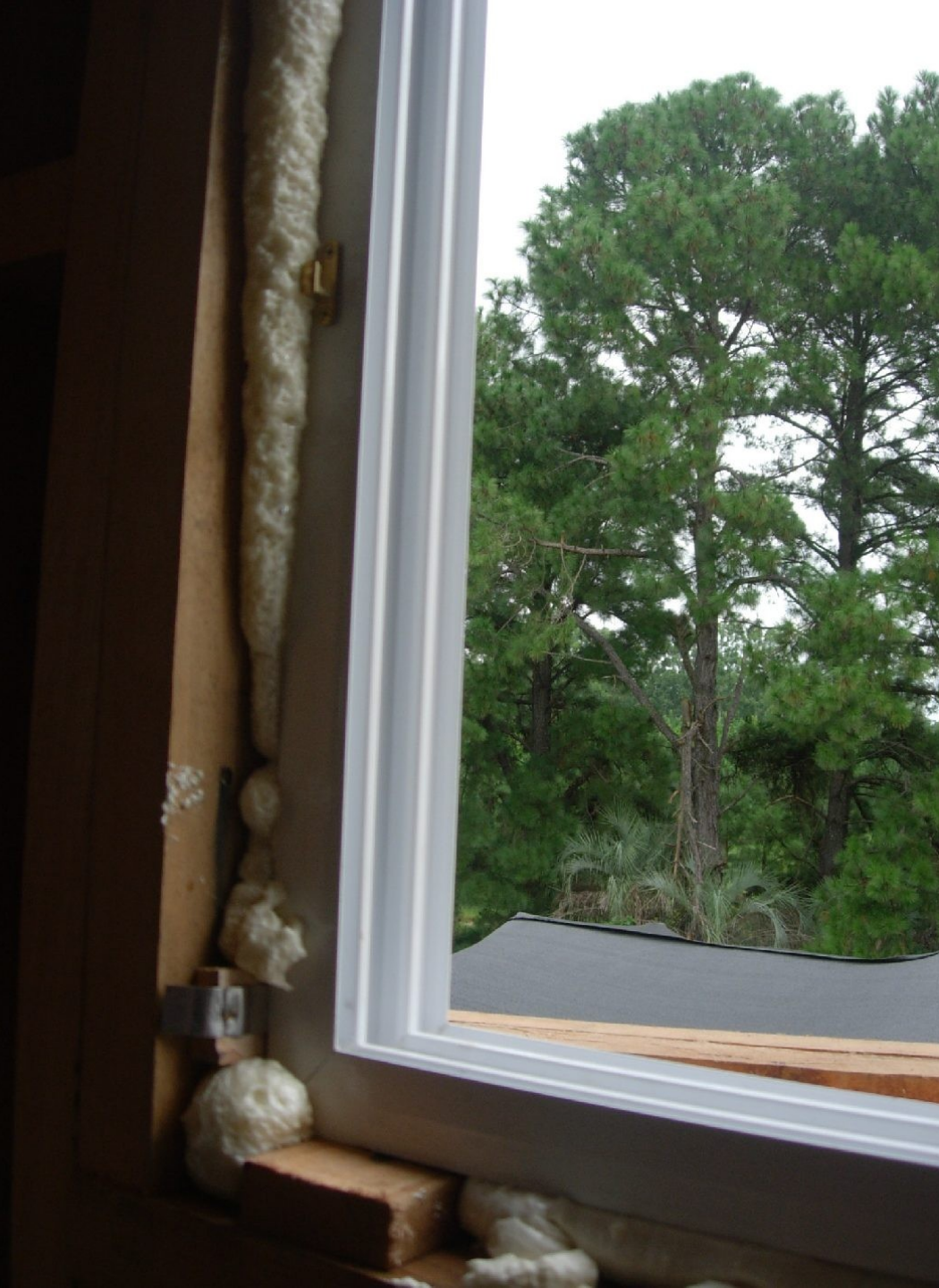
Sellado y fijación Con espuma de poliuretano
