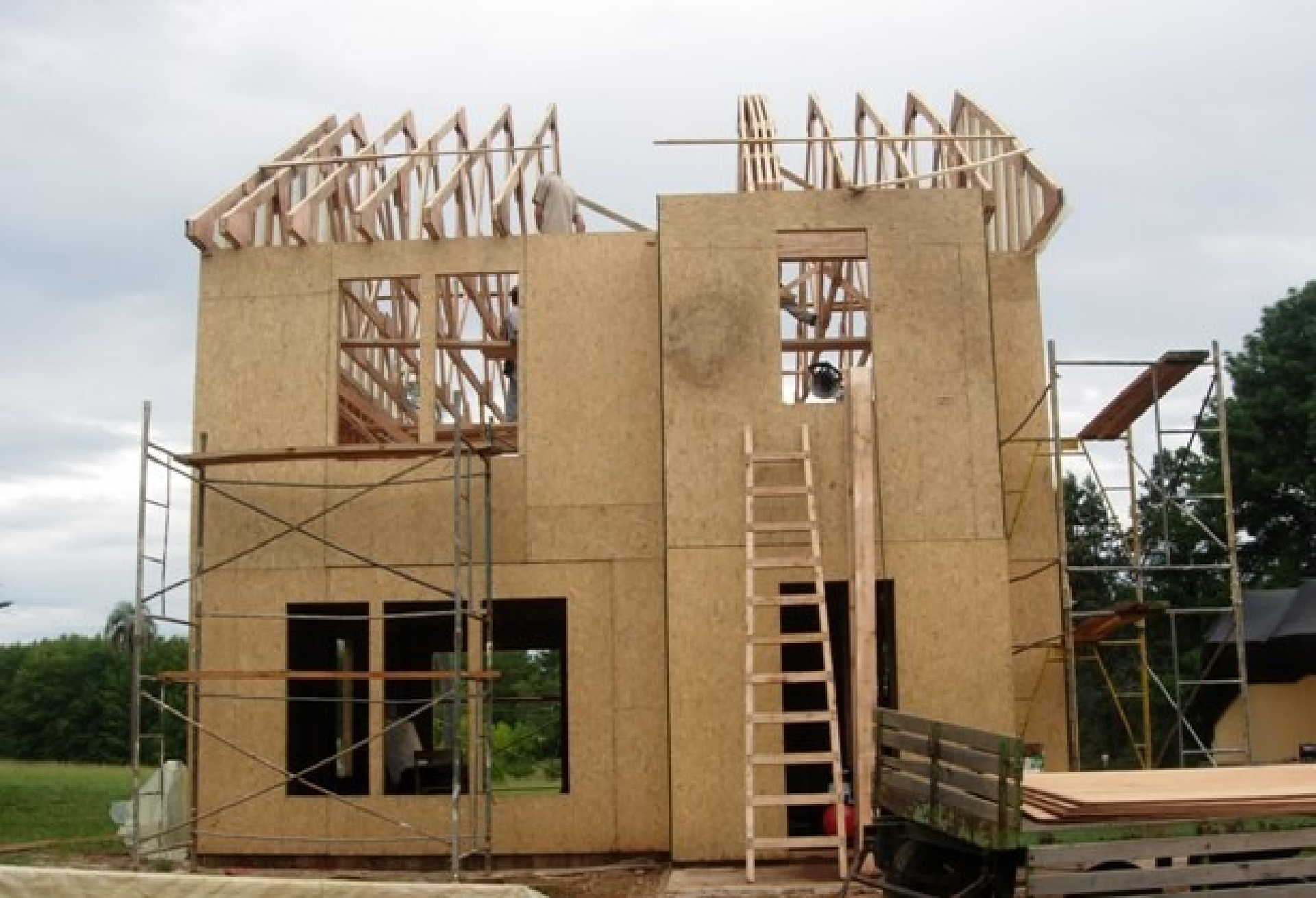
Fijado de segundo timpano y distribución de las cabriadas apiladas
