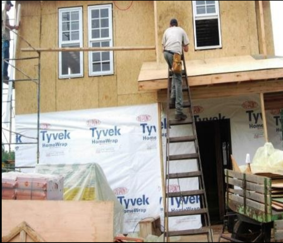
Instalación primer piso
