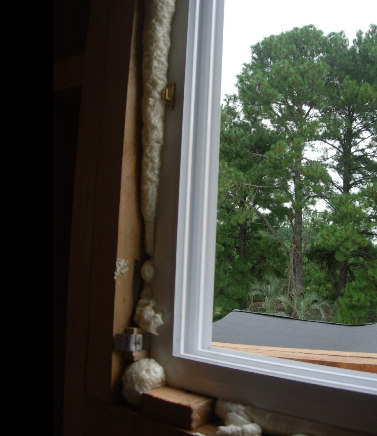
Sellado y fijación Con espuma de poliuretano
