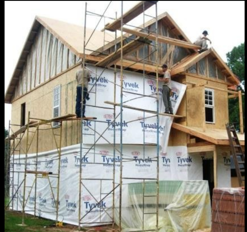
Instalación segundo piso
