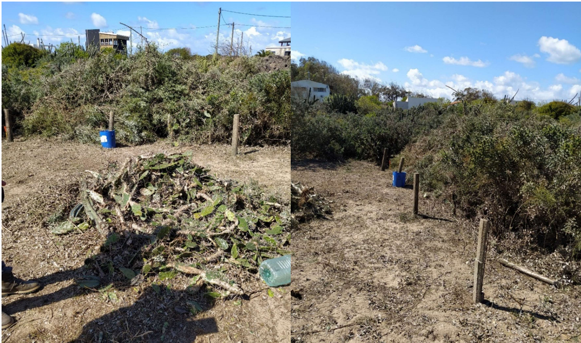
Figura 7: Eliminación del tapiz vegetal para preparar el terreno para una futura construcción. Fotografía: Lucía Puppo, 20/9/20.
