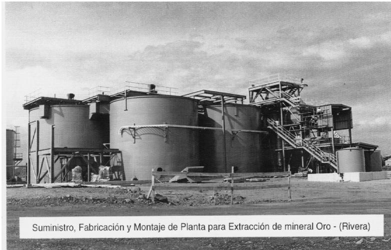
Figura Nº 7-12. Tanques de lixiviación en carbono activado (tarjeta de CIR de 1997-98)
