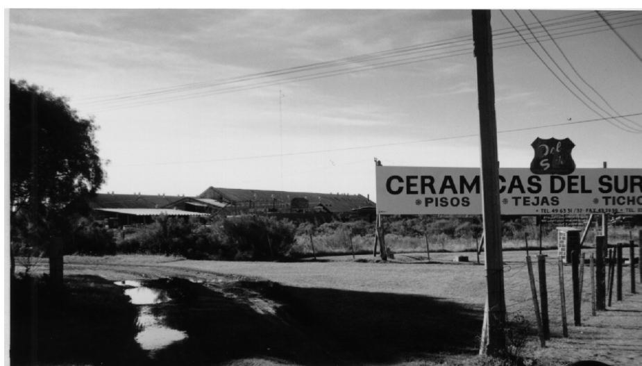
Figura Nº 5-3- Planta industrial de cerámica roja de la empresa Cerámica del Sur Km37 de la ruta Nº1, Dpto San José
