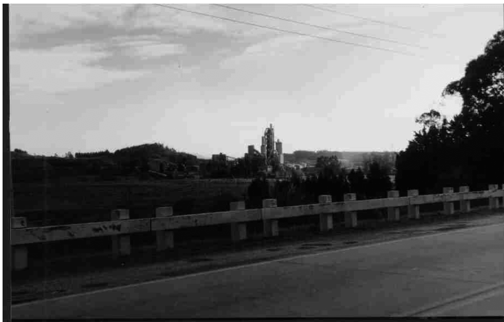
Figura N° 5-5 -Vista panorámica de la Compañía uruguaya de Cemento portland desde ruta N°8; Verdún, Dpto de Lavalleja.
