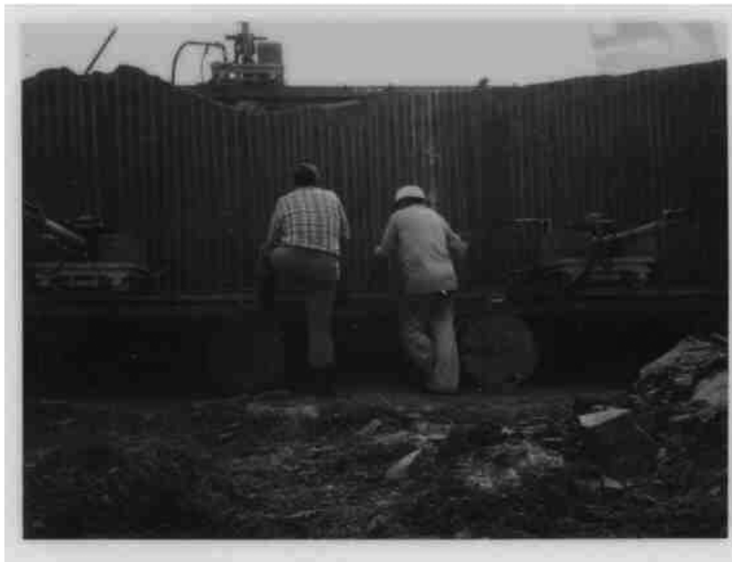
Figura N° 5-4- Primer frente de cantera de granito negro en Uruguay preparado con cortina de barrenos; canteras TALITA, dpto de Florida (Año 1978).
