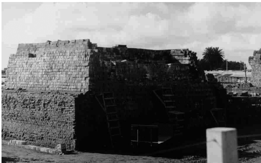
Figura N° 5-7- Horno de ladrillo de elaboración artesanal de la empresa Rodriguez y Suárez en la calle Cochabamba (Dpto de Montevideo)
