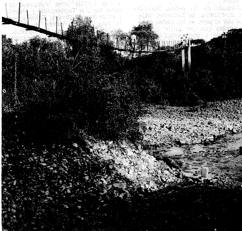
Puente colgante en Valle Edén.
