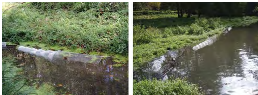
Figura 15.2: Detalle de nasas instaladas en un arroyo
