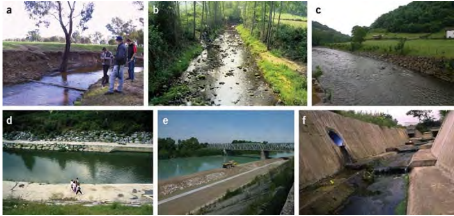
Figura 17.4: Ejemplos de algunas afecciones a la conectividad lateral
