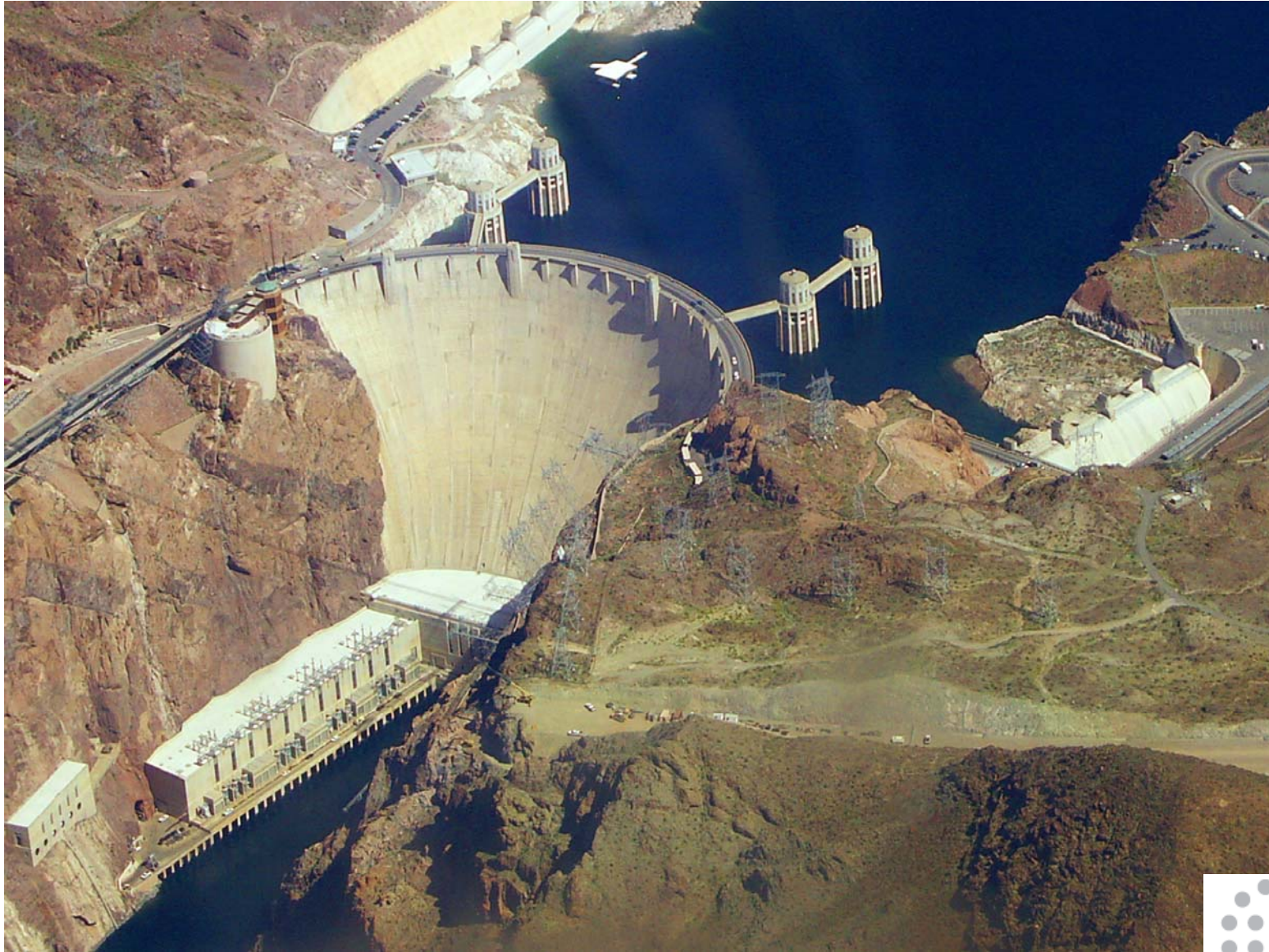
Hoover Dam (USA)
